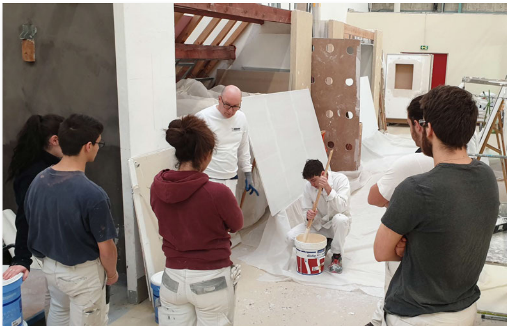
Application de la première couche du produit d'imperméabilisation
