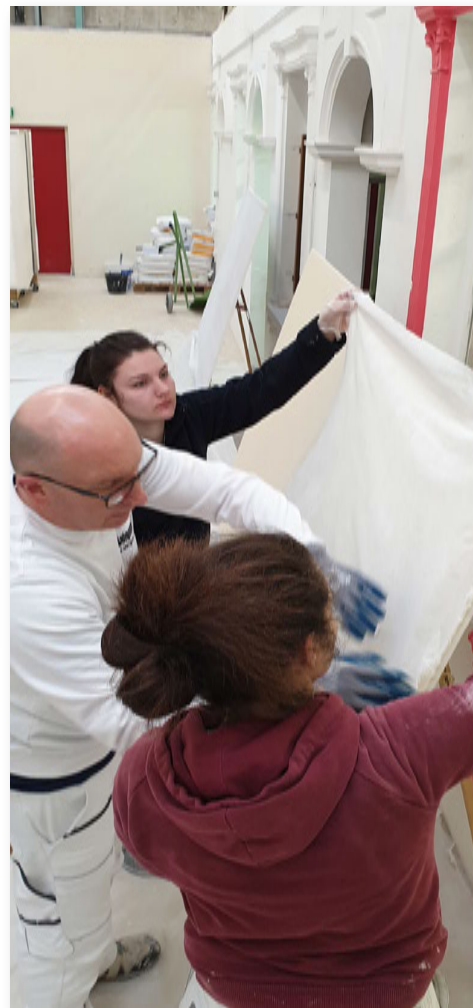
Application de la première couche du produit d'imperméabilisation
