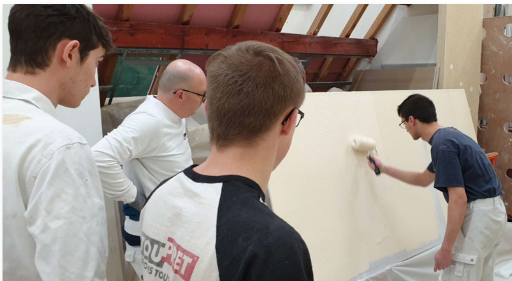
Application de la première couche du produit d'imperméabilisation
